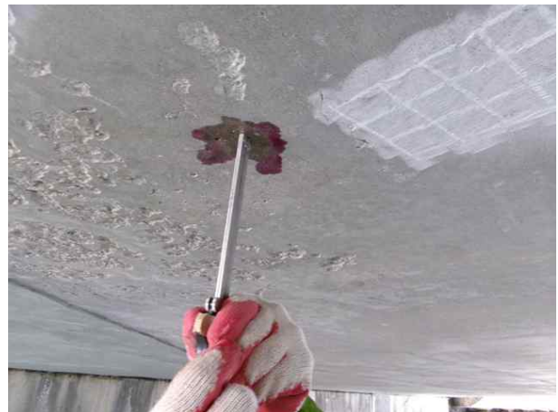
탄산화깊이 측정 현황
